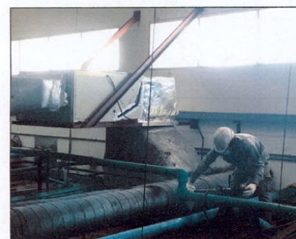
ภาพที่ 1 การเก็บตัวอย่างอากาศจากปล่องระบายอากาศ ปล่องระบายอากาศ UV
